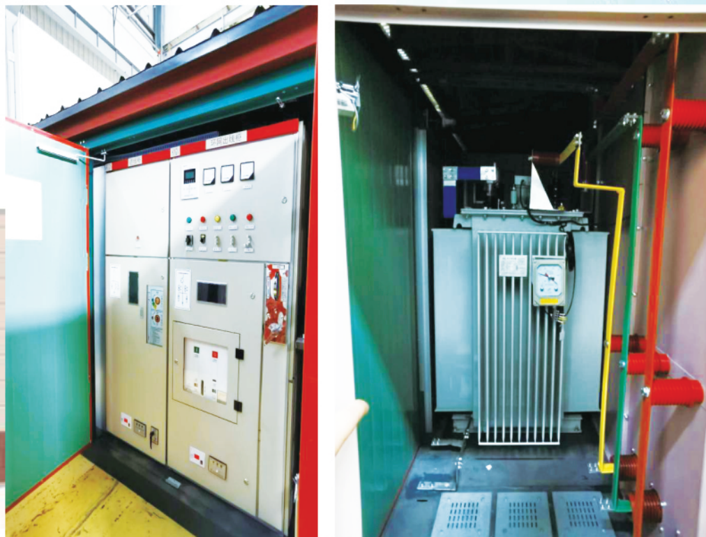
图1-4 箱式变压器实景图
