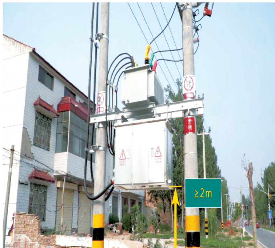
图1-3 台架式变压器实景图
